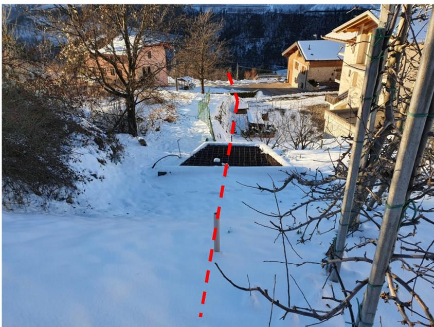
Foto 4: come si vede l’area oggetto di variante a sx è sopraelevata di alcuni metri rispetto alla tubazione (linea rossa tratteggiata); una eventuale esondazione da monte interesserebbe il piazzale a dx della foto
